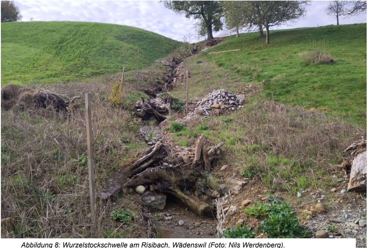
Abbildung 8: Wurzelstockschwelle am Risibach, Wädenswil (Foto: Nils Werdenberg).
