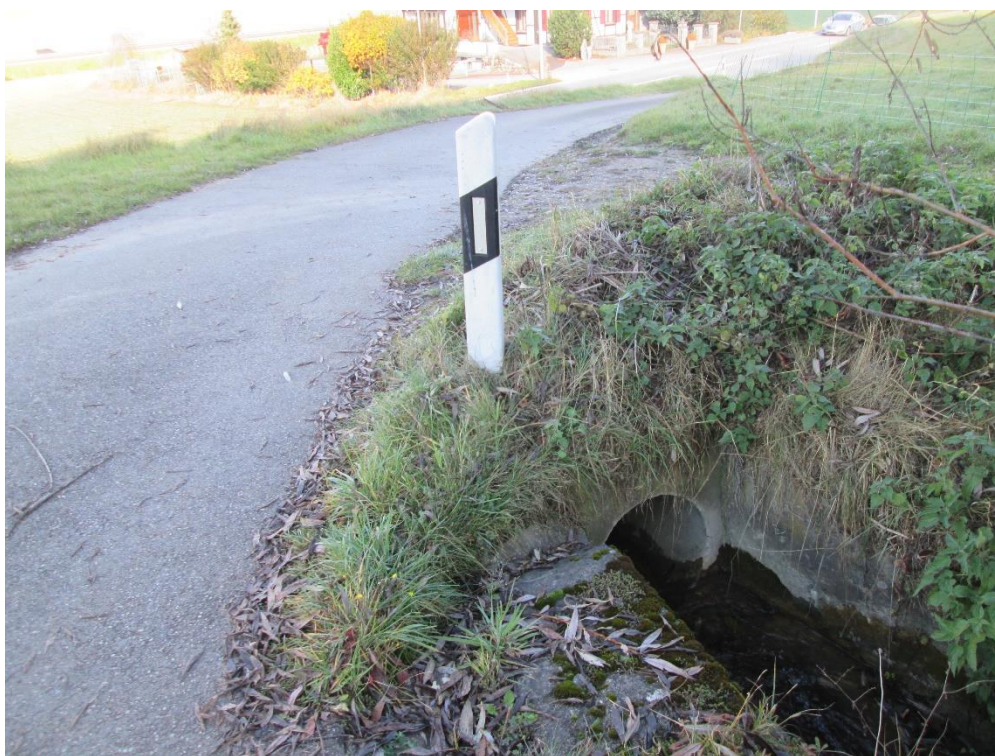
Abbildung 14: Eindolung oberhalb Freiburgstrasse (Blick in Fliessrichtung).
