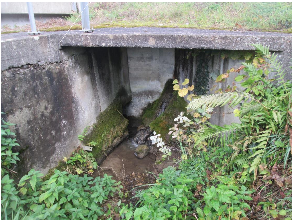
Abbildung 8: Durchlass SBB / A2 (Blick in Fließrichtung). Der Reinharderebach fließt im Bild links in Richtung Stadtbach. Rechts auf dem Bild ist die Einmündung des eingedolten Studweidbachs ersichtlich.
