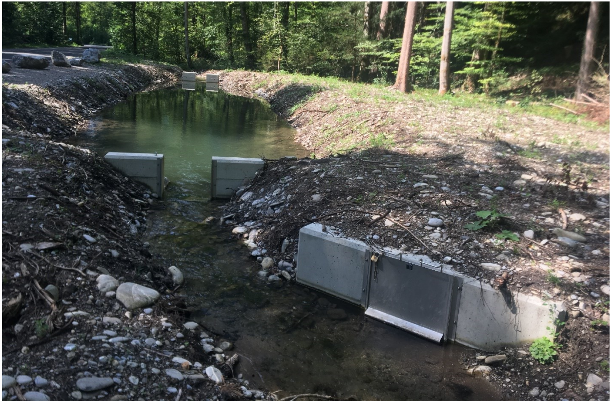
Abbildung 9: Sandfang am Allmendingenbach bei Thun (Foto: Kissling + Zbinden AG). Der Einlauf für die Wasserhaltung ist am rechten Bildrand zu sehen. Das Becken ist deutlich länger als die im vorliegenden Projekt geplanten Sandfänge.
