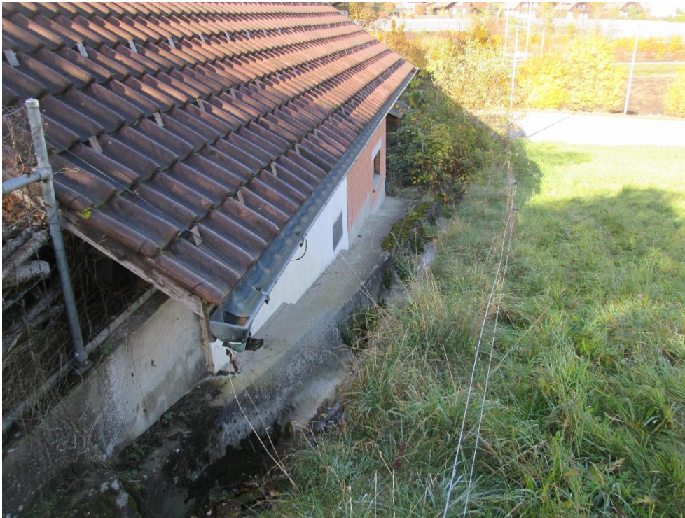
Abbildung 3: Bachschale (Beton) oberhalb Freiburgstrasse (Blick in Fließrichtung).
