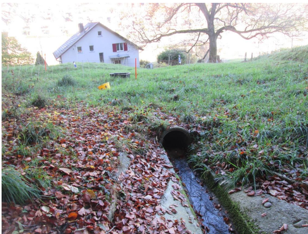
Abbildung 10: Eindolung direkt unterhalb Rückhaltebauwerk (Blick in Fliessrichtung).
