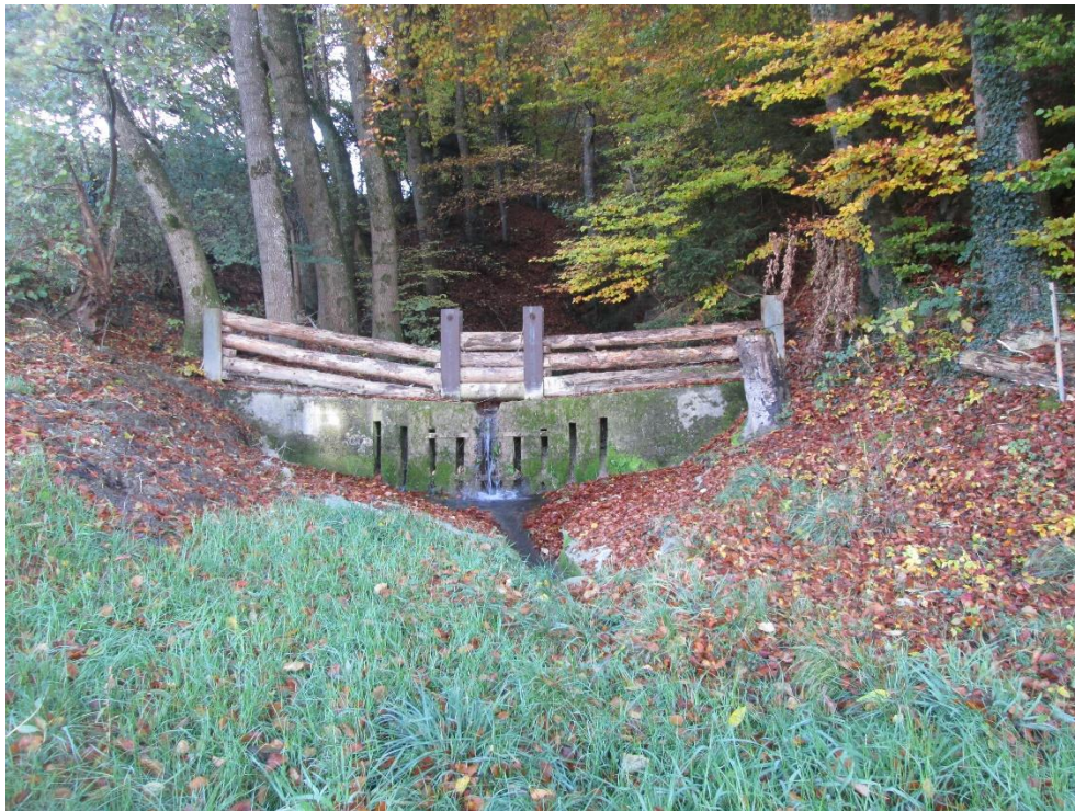
Abbildung 9: Rückhaltebauwerk am Waldrand (Blick gegen Fliessrichtung).
