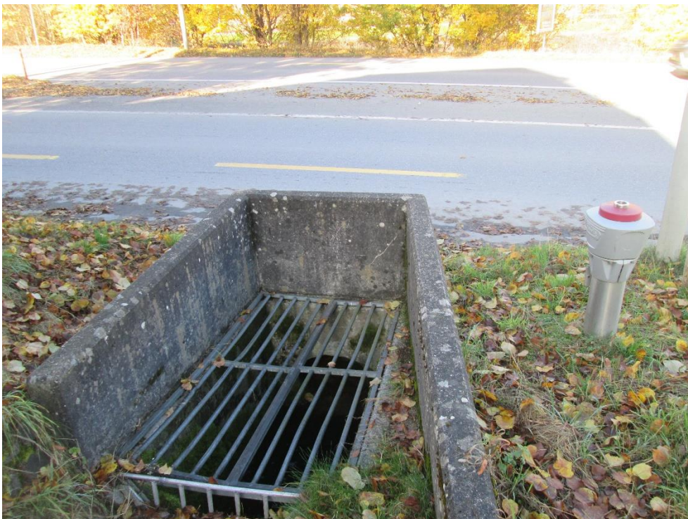
Abbildung 4: Einlaufbauwerk bei Eindolung Freiburgstrasse (Blick in Fließrichtung).
